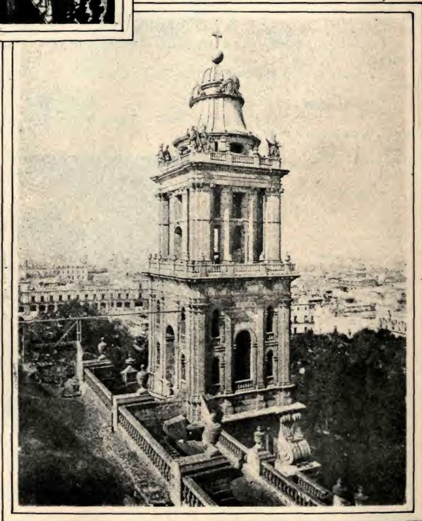
Torre del lado del Poniente
